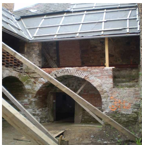
Výsledek projektu: provizorní zastřešení, statické zabezpečení
