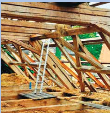
Krov hospodářského objektu v Nemilkově po sejmutí střešní krytiny.
