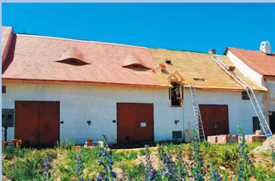
Postupná obnova střech v hospodářském areálu zámku Nemilkov.
