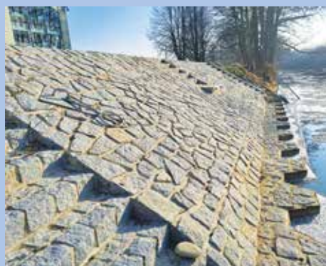
Upravené břehy řeky v Horažďovicích (IROP).
