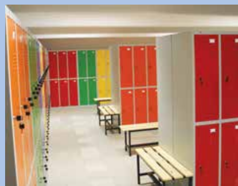
Rekonstrukce šaten v ZŠ Klatovy, Čapkova ul.
