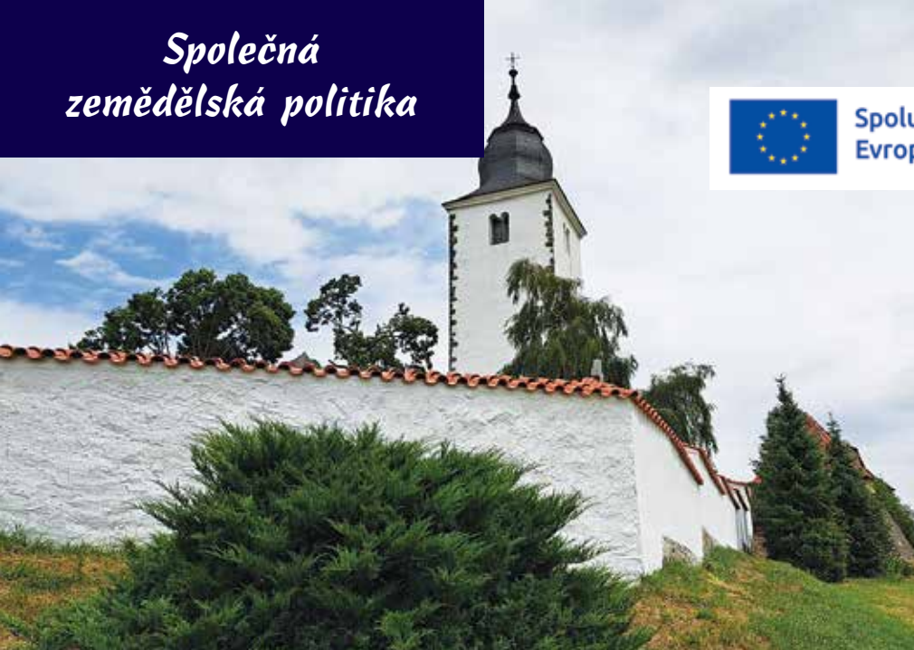
Rekonstrukce hřbitovní zdi u kostela sv. Vavřince na Zdouni.
